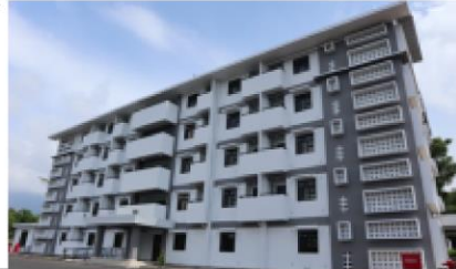
ITB JATINANGOR FLATS, SUMEDANG
